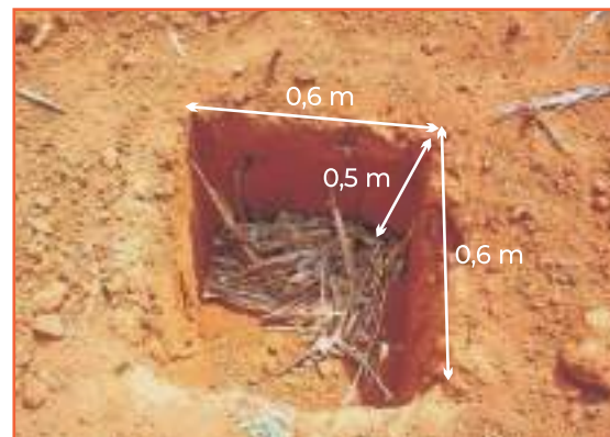
Đào hố thủ công
